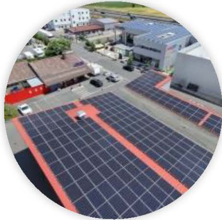
Sukzessive Umstellung auf Ökostrom & flächendeckende Installation PV-Anlagen
