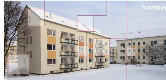
Anheben der Dachfläche für zusätzlichen Wohnraum, Ausdämmen des Dachstuhls Es entstehen neue, attraktive Dachgeschosswohnungen. Durch die Dämmung wurde der Energieverlust von 2,10W/m 2 K auf weniger als ein Viertel reduziert.
