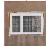
Vollständige Fenstererneuerung Die neuen Fenster verringern den Wärmedurchlasskoeffizienten von 2,70W/m 2 K auf 1,10W/m 2 K.
