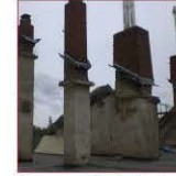
Erneuerung der Heiztechnik Allein durch neue Brennwertechnik konnte der Energieverbrauch um 20% reduziert werden. Die Heizkosten werden gerecht ermittelt.
