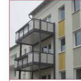
Balkonsanierung & z. T. Vorstellbalkone Alte Balkone wurden umfassend saniert, große Wohnungen erhielten einen Vorstellbalkon adäquat ihrer Größe.
